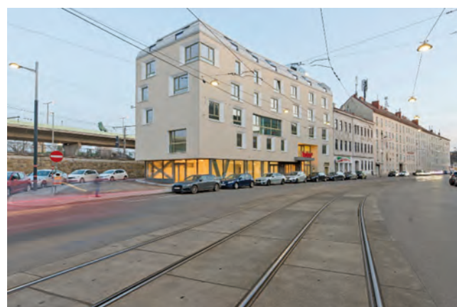
Abb. 5: Der im Herbst 2022 fertiggestellte Volkshilfe Hafen
