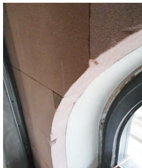
Abb. 7: Ausbildung Innendämmung an halbrunden Fensterelementen vor Applikation der Leibungsdämmung
