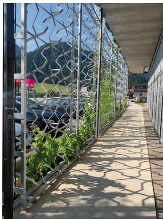
Rankgerüste montiert, erster Bewuchs, Foto ©: MPREIS
