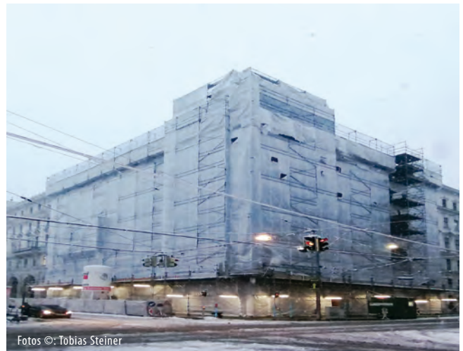
Abb. 4: Baustelle im Winterbetrieb
