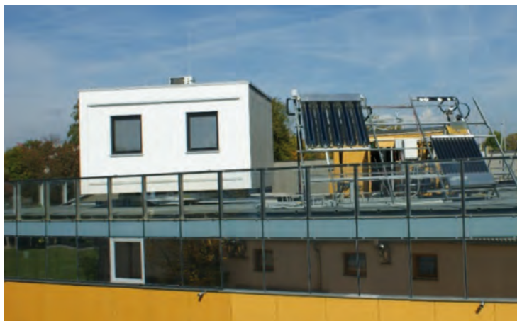
Abb. 2: Fassadenprüfbox der AEE INTEC; Außenaufnahme und Grundriss
