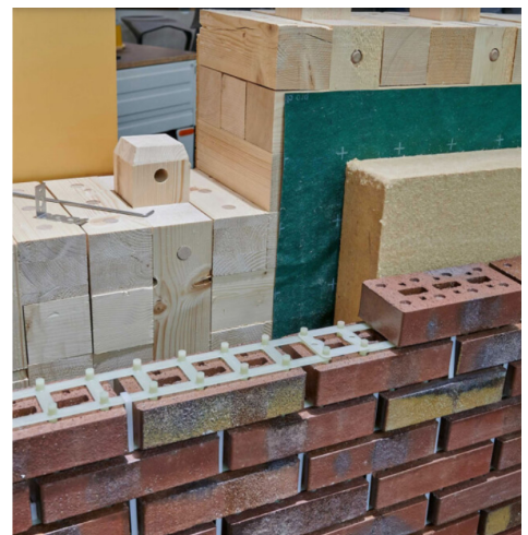
Abb. 6: Zerstörungsfrei rückbaubare TRIQBRIQ Massivholzwand © Baubild, Stephan Falk
