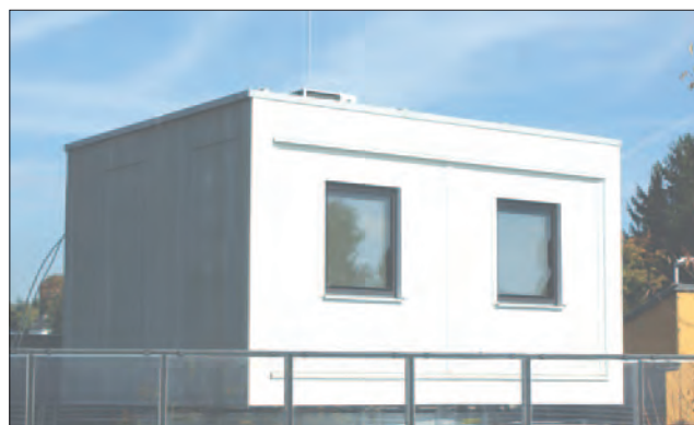
Die drehbare fertige Fassadenbox mit der Standardfassade auf dem Dach des Prüflabors der AEE INTEC in Gleisdorf
