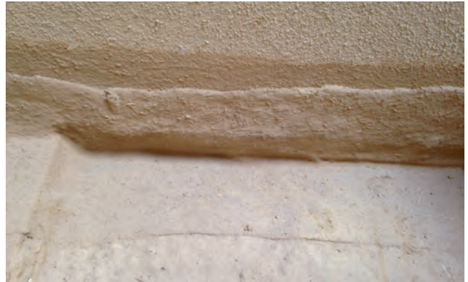
Mit Lehmschlämme getränktes Flachsvlies als Abdichtung, Foto: © Andi Breuss
