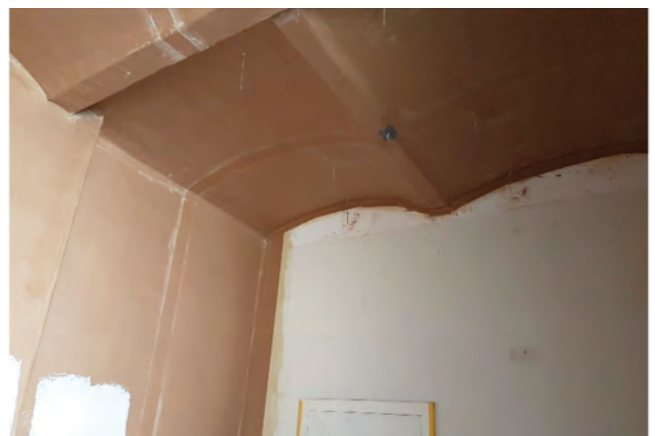
Flächig aufgebrachte gasdichte aluminium-kaschierte Tapete der Firma Valutect mit sorgfältig ausgeführten dauerhaft luftdichten Anschlüssen
