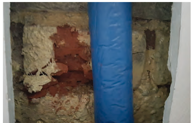
Probenahme aus der originären Ziegelwand hinter der Vorsatzschale für chemische Analyse und Geruchsprüfung
